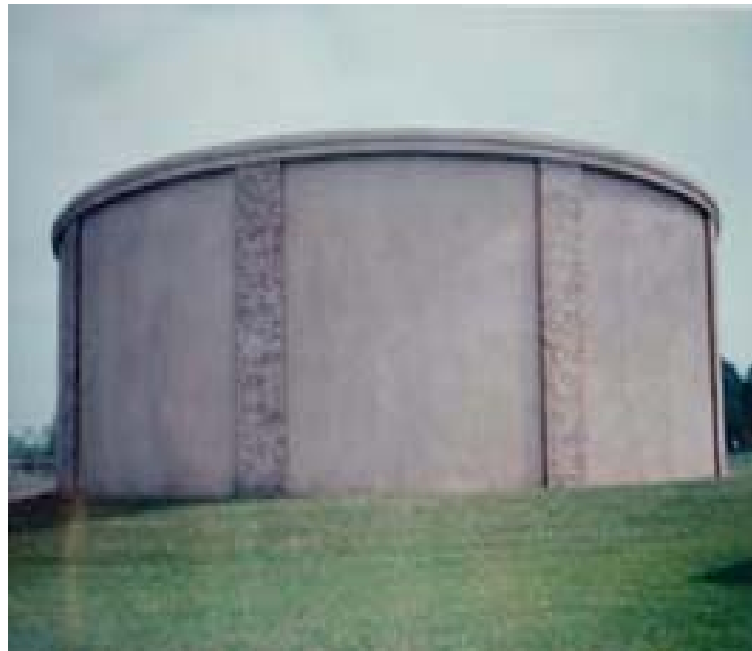
شكل (٩,٢): خزانات منشأة من الخرسانة المسلحة.
